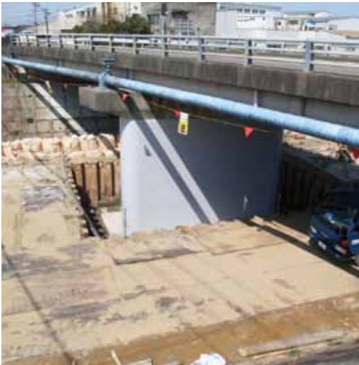
施 工／(株)安部日鋼工業
