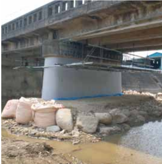
施 工／(株)安部日鋼工業
