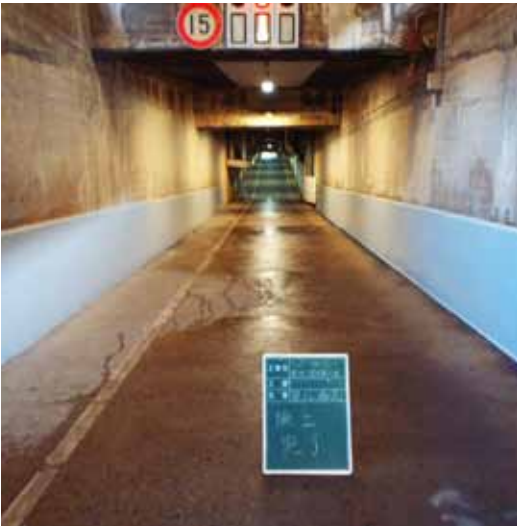
施 工／(株)安部日鋼工業
