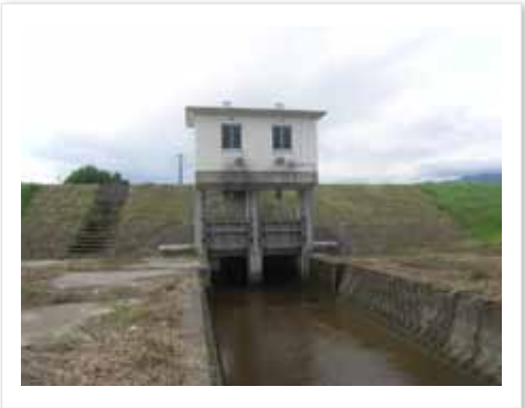
ニッ島第2樋管全景
