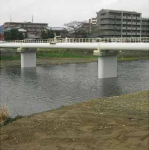
施 工／(株)アーテック
