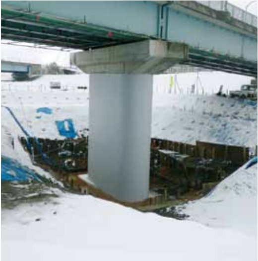
施 工／(株)大熊工業
