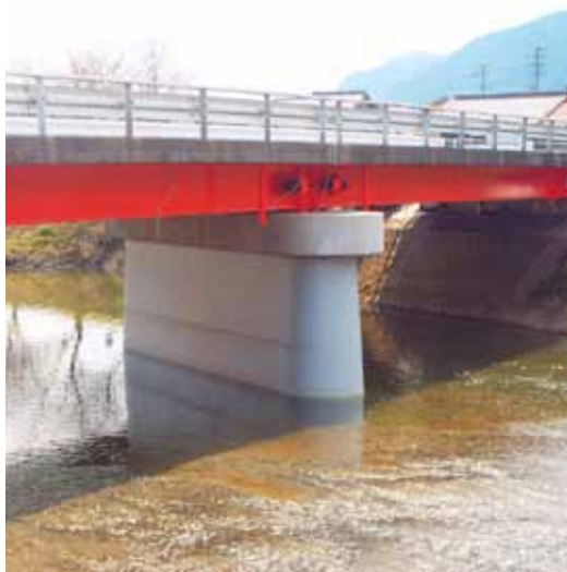
施 工／(株)安部日鋼工業
