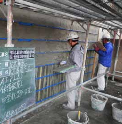
施 工／福美建設(株)
