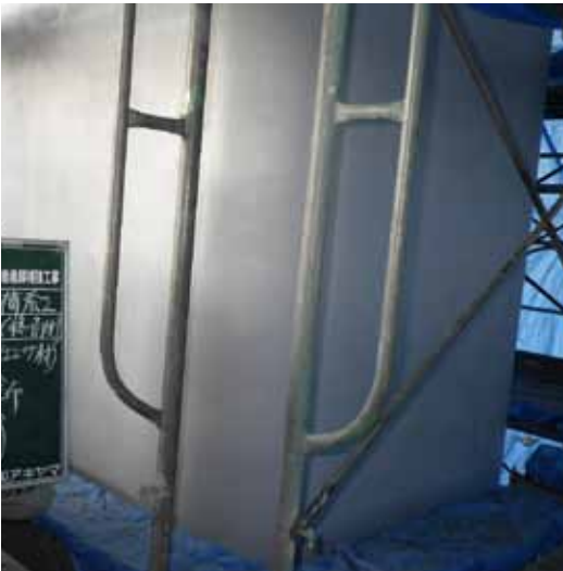
施 工／福美建設(株)
