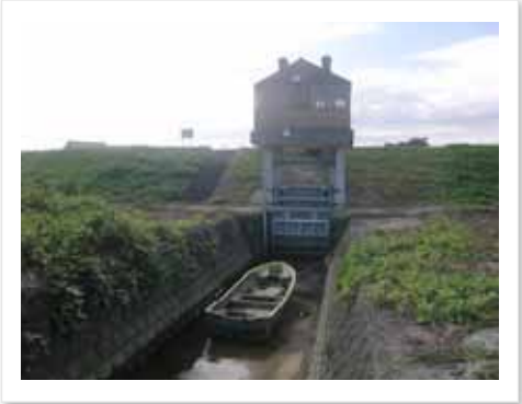
ニッ島第1樋管全景
