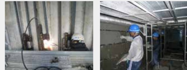
④ガス圧接
