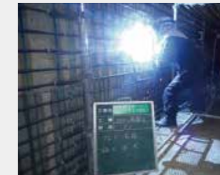
④フレアー溶接
