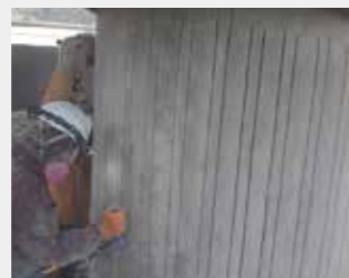
④埋設溝切削
