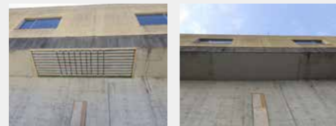
④配力筋固定
