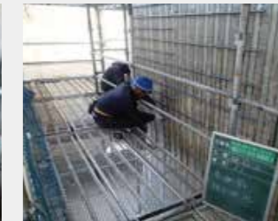
③帯鉄筋固定
