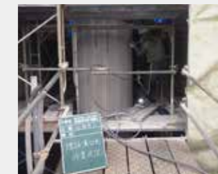
③埋設溝切削
