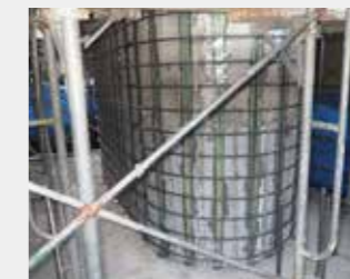
④帯鉄筋固定
