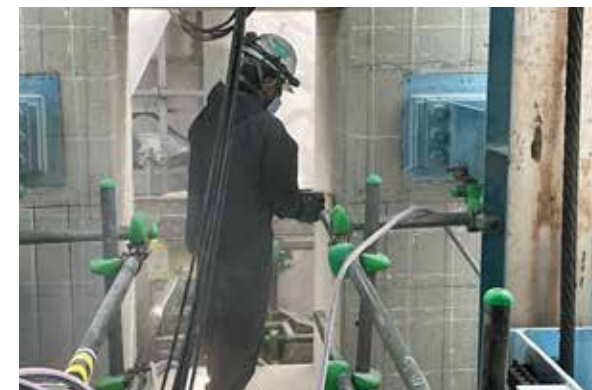
③埋設溝切削
