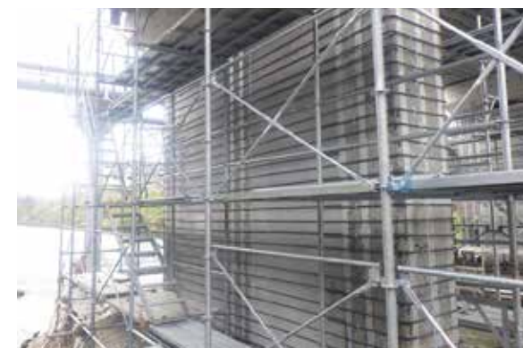
③帯鉄筋固定
