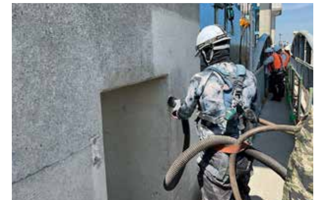
②下地処理工
