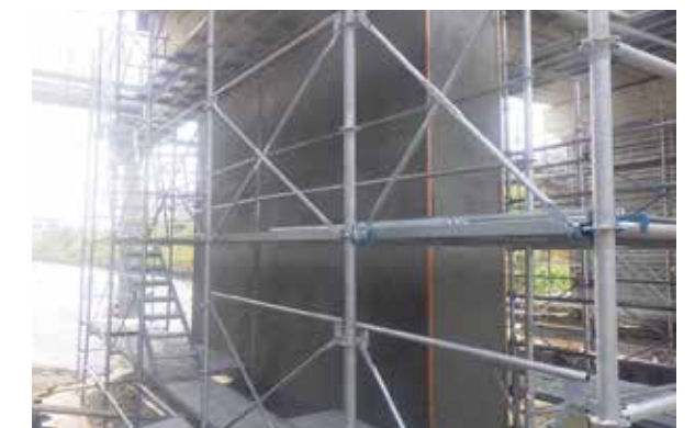
④保護被覆工(中塗り)
