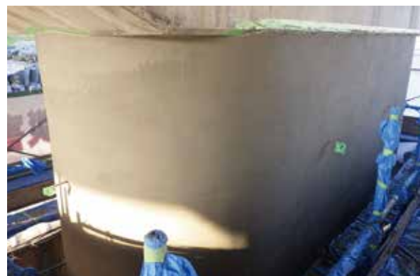
⑤保護被覆工(中塗り)
