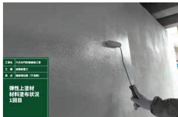
⑤保護被覆工(仕上げ)
