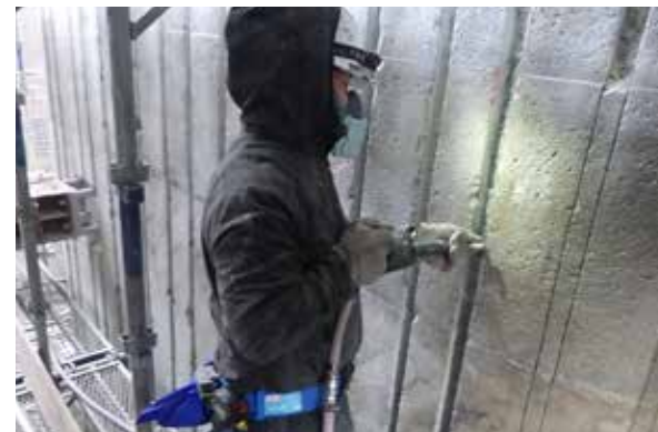
②埋設溝切削
