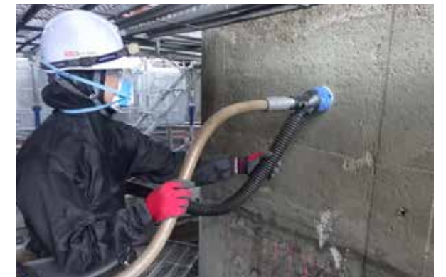
②下地処理工
