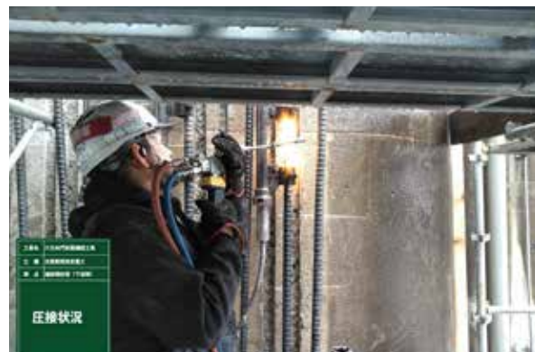
③ガス圧接
