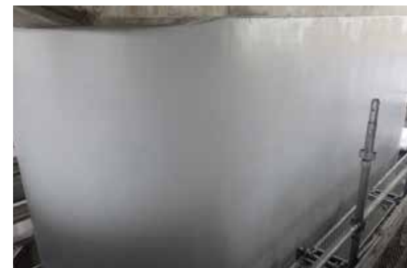
⑤保護被覆工(仕上げ)
