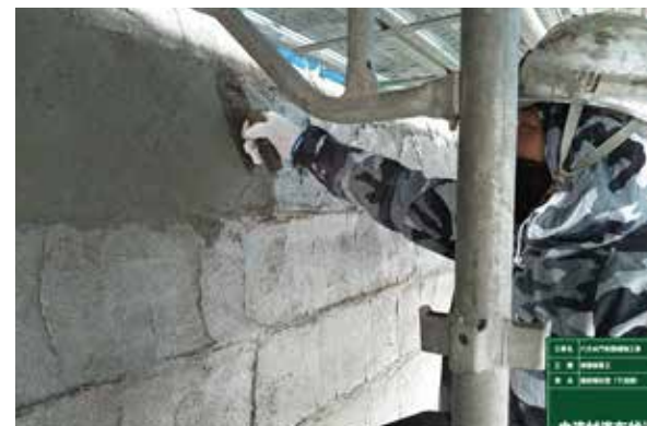
④保護被覆工(中塗り)
