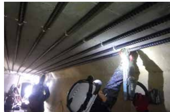
②主鉄筋固定
