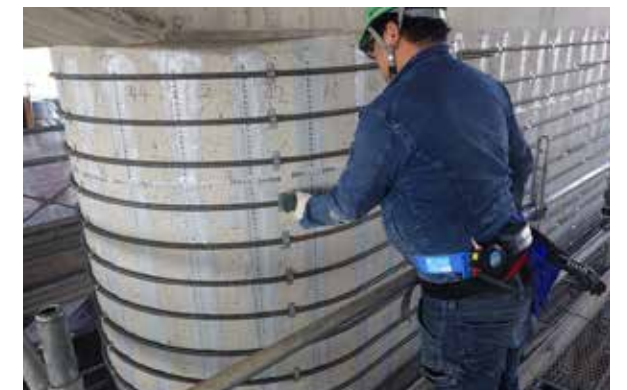
④帯鉄筋固定
