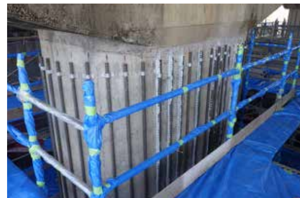
④埋設溝定着・主鉄筋固定
