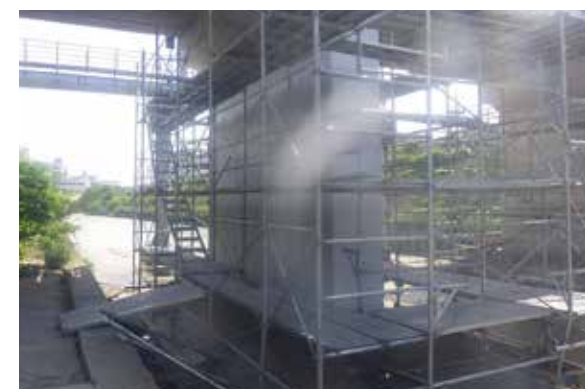
⑤保護被覆工(仕上げ)
