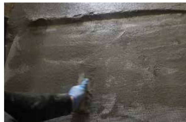
⑤補強ネット貼付け
