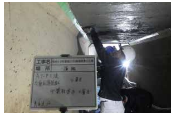
④保護被覆工(中塗り)
